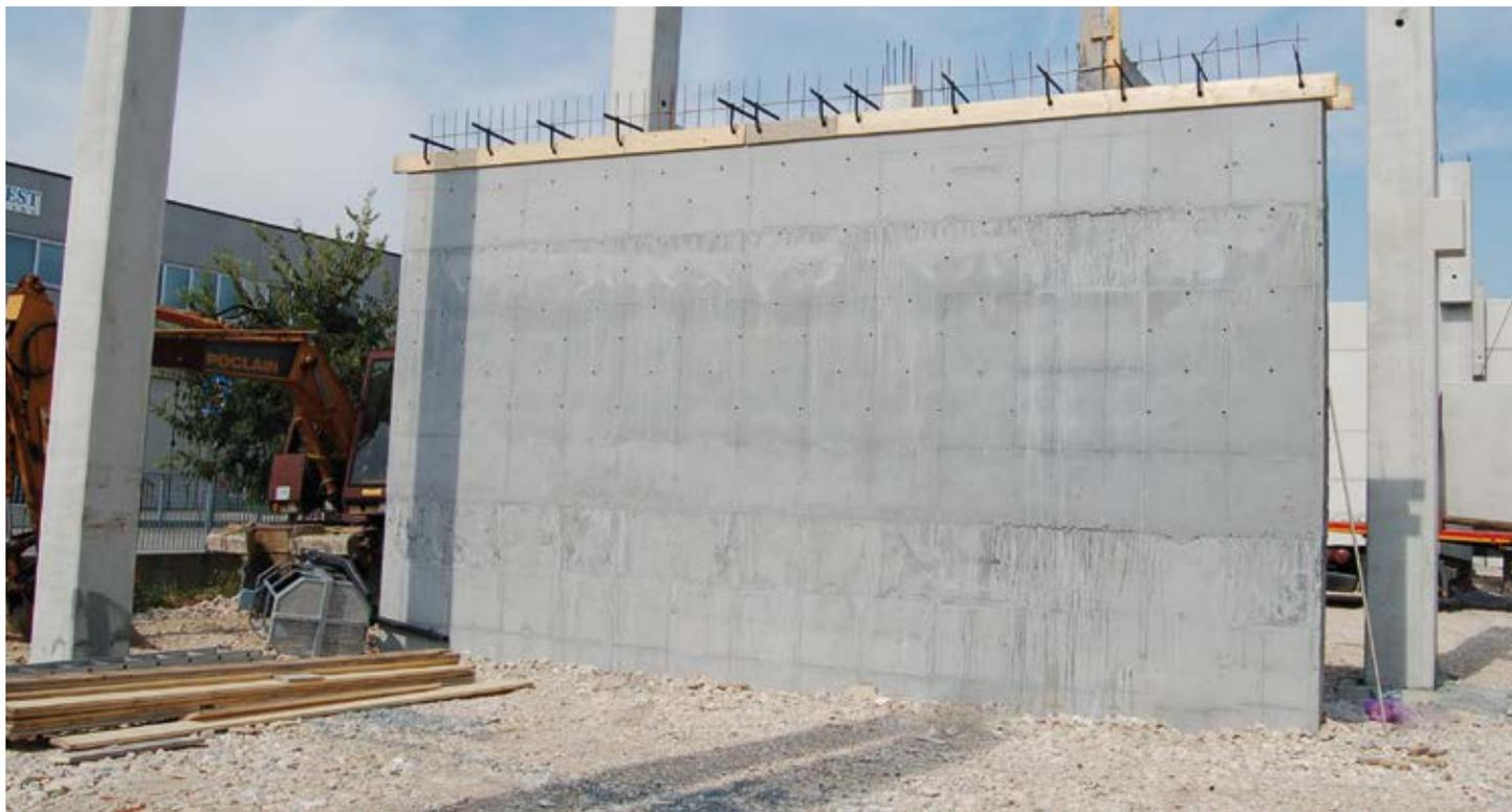
GEOPANEL — это простая и интуитивно понятная система модульных элементов опалубки из ABS для создания сооружений, фундамента и пилоастров из бетона.
