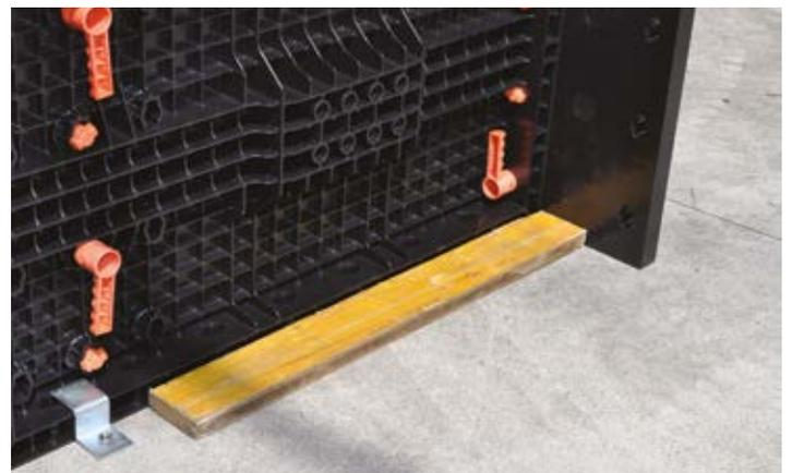
Крепление к земле может осуществляться с использованием деревянных досок, скоб или анкеров. Этот метод крепления позволяет предотвратить подъем панелей.
