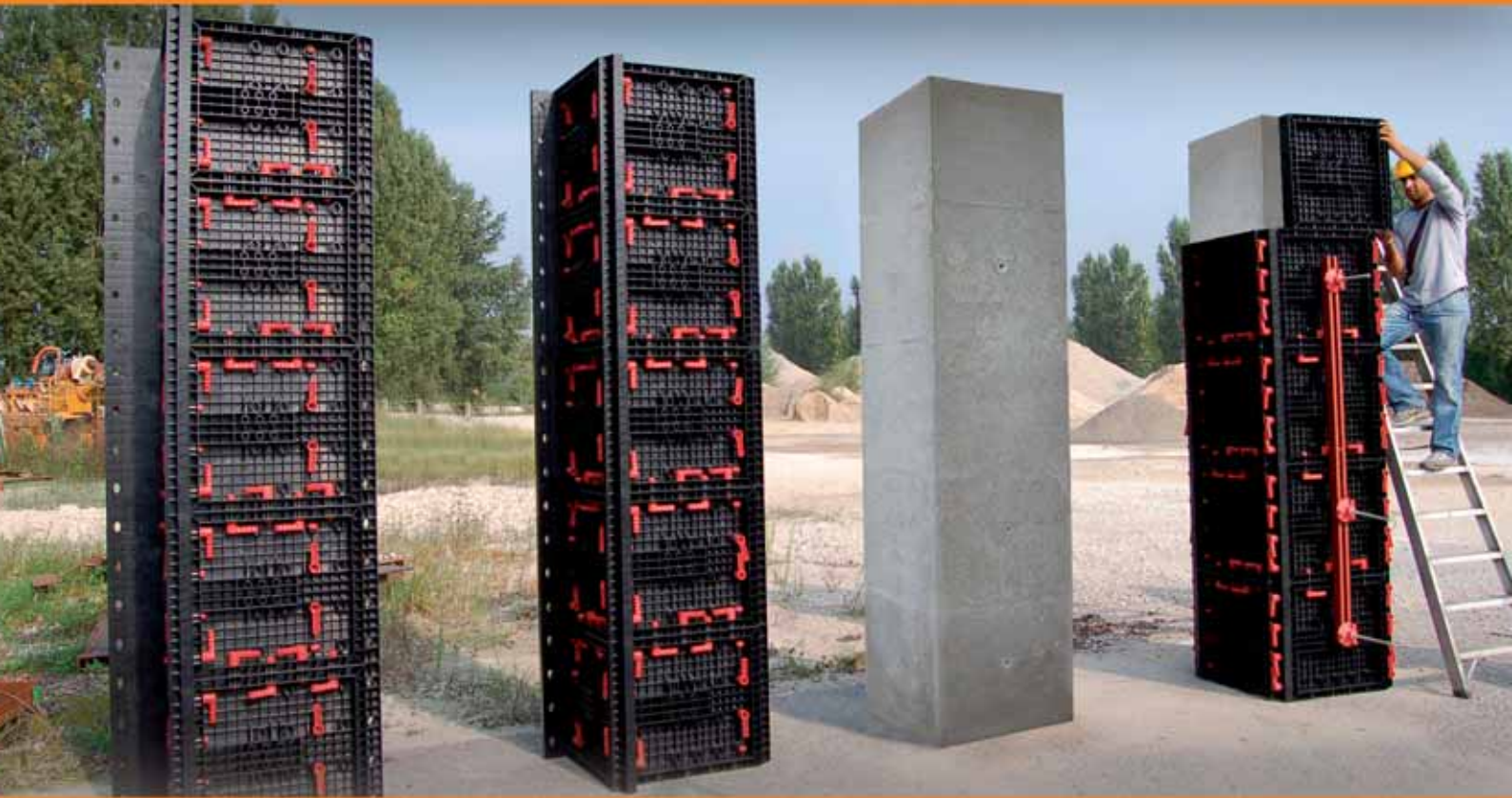
Универсальная многоуровневая опалубка для колонн
